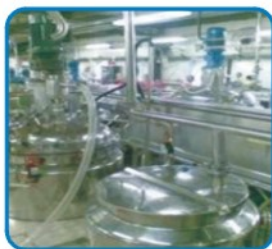
不锈钢管道自动焊工程
