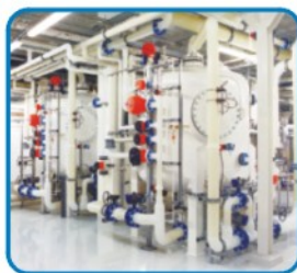
高纯PVDF管道安装工程
